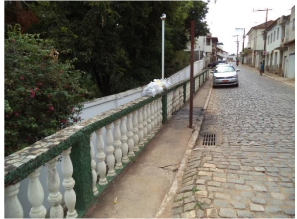
FIGURA 74 - DRENAGEM SUPERFICIAL (FONTE: ACERVO DO AUTOR, 2014)
