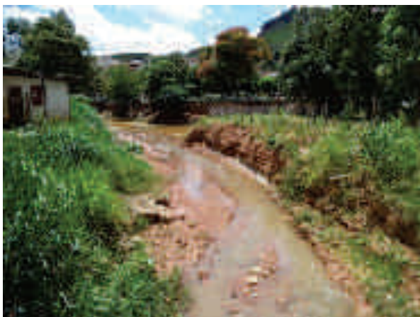
FIGURA 40 - PONTO DE DESPEJO DE ESGOTO IN NATURA CÓRREGO DOS DUQUES (FONTE: ACERVO DO AUTOR, 2014)
