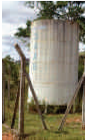
FIGURA 32 - RESERVATÓRIO DA LOCALIDADE DE BARROSO (FONTE: ACERVO DO AUTOR, 2014)
