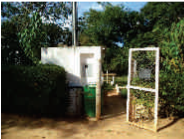
FIGURA 42 – ENTRADA DA ETE DO DISTRITO DE GRANADA (FONTE: ACERVO DO AUTOR, 2014)
