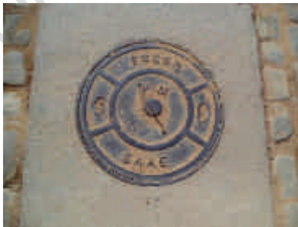
FIGURA 39 - POÇO DE VISITA (FONTE: ACERVO DO AUTOR, 2014)
