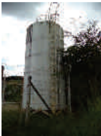
FIGURA 38 - RESERVATÓRIO DA LOCALIDADE DE CACHOEIRA DO LIVRAMENTO (FONTE: ACERVO DO AUTOR, 2014)
