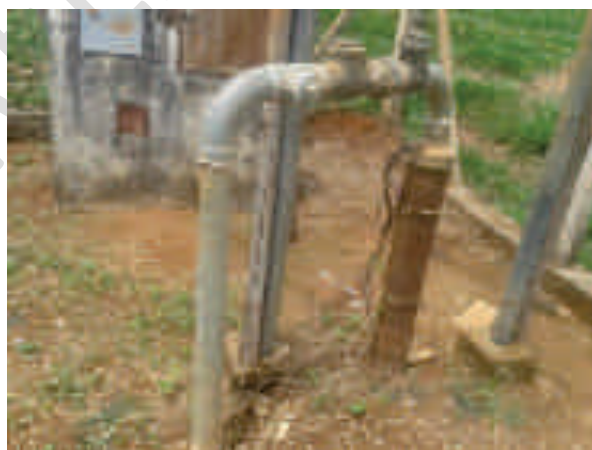
FIGURA 37 - POÇO DA LOCALIDADE DE CACHOEIRA DO LIVRAMENTO (VISTA 2) (FONTE: ACERVO DO AUTOR, 2014)
