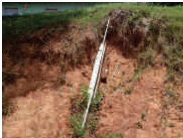
FIGURA 49 - LANÇAMENTO DE ESGOTO NA LOCALIDADE DE APARECIDA (VISTA 2) (FONTE: ACERVO DO AUTOR, 2014)
