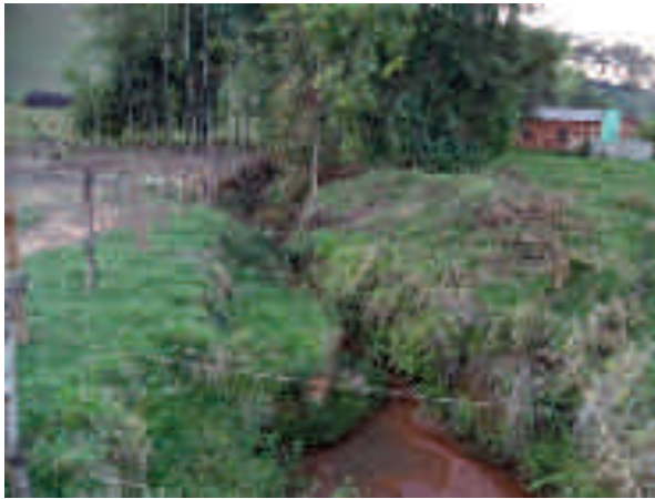
FIGURA 44 - LANÇAMENTO DE ESGOTO NO CÓRREGO SANTA EFIGÊNIA (FONTE: ACERVO DO AUTOR, 2014)
