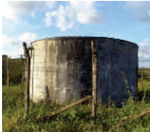
FIGURA 27 - RESERVATÓRIO DA LOCALIDADE DE GRANADA (FONTE: ACERVO DO AUTOR, 2014)
