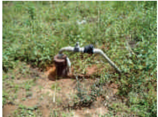
FIGURA 34 - POÇO DA LOCALIDADE DE APARECIDA (VISTA 2) (FONTE: ACERVO DO AUTOR, 2014)
