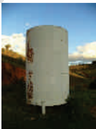
FIGURA 29 - RESERVATÓRIO DA LOCALIDADE DE SANTA EFIGÊNIA (FONTE: ACERVO DO AUTOR, 2014)
